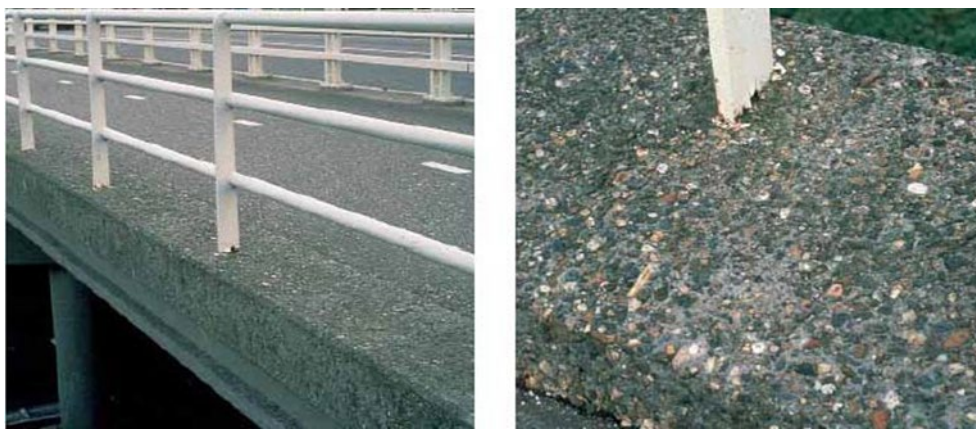
Foto 1 Betonnen rand van een viaduct
