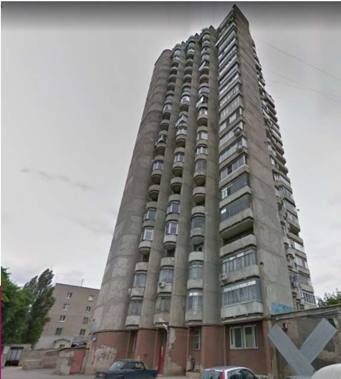
Figuur 1. Appartementencomplex uit 1994 van 24 verdiepingen gebouwd met alkalisch geactiveerde slak in Lipetsk, Rusland [8] (foto: Google Street View – juli 2015)
